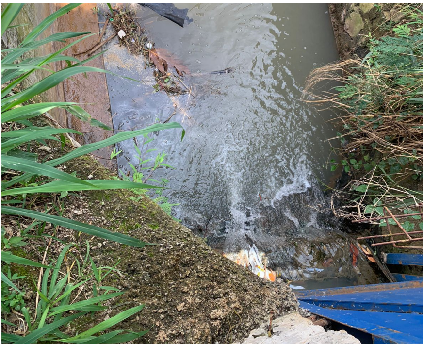
Kondisi Drainase di Sekitar Lokasi BH 766
