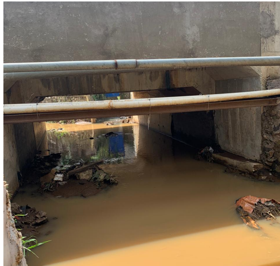
Gambar 4.1 Kondisi Eksisting BH 766
