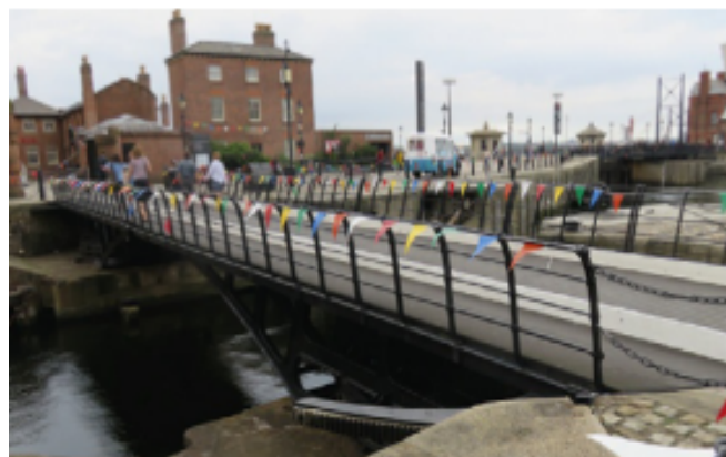
Gambar 2.11 Jembatan Berputar di Liverpool Sumber: (Lin & Yoda, 2017)
