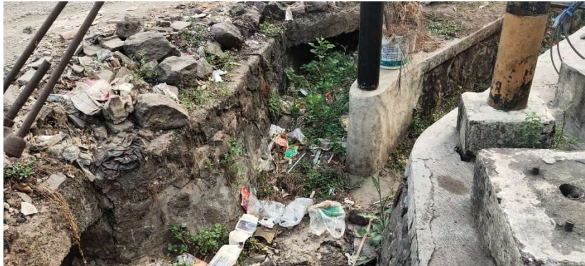
Gambar 5 Kondisi Sistem Drainase Di Jalan Prabu Gajah Agung
