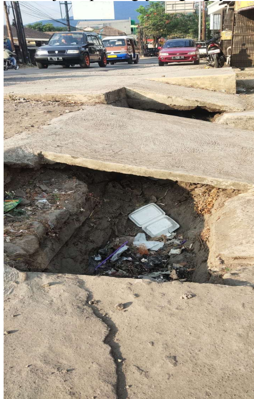
Gambar 4 Kondisi Sistem Drainase Di Jalan Prabu gajah Agung
