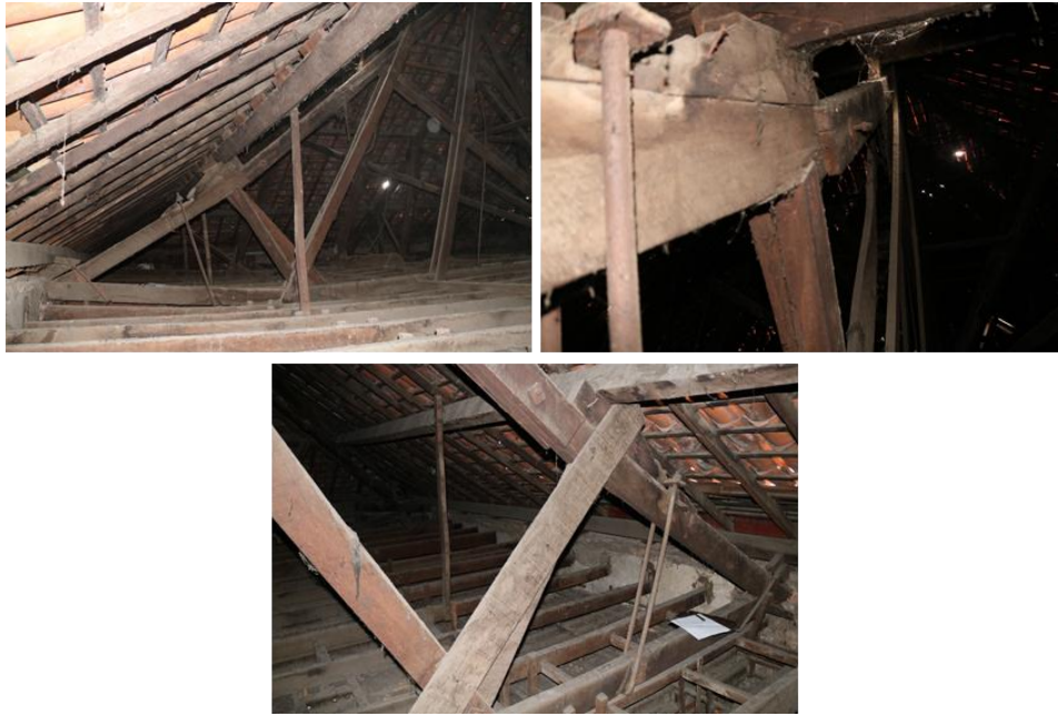
Gambar 2.6 Kondisi Struktur Atap
